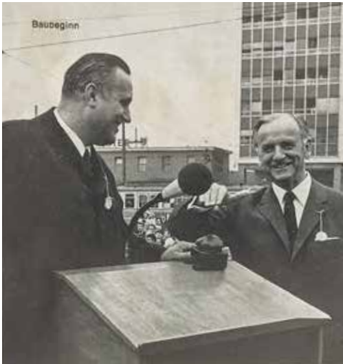
Landesverkehrsminister Dr. Fritz Kassmann (r.) und Oberbürgermeister Heinrich Sondermann gaben am 22. Oktober 1969 das Startzeichen zum Bau der Stadtbahn in Dortmund.
